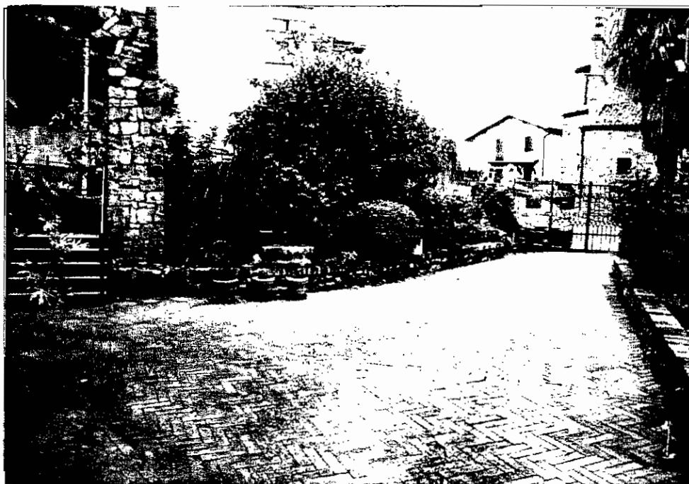
Ingresso al fabbricato (part.lla 352 – lotto A) Foto n° 5
