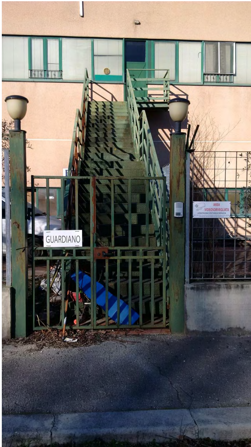
Foto 13 SCALA IN ACCIAIO ATTUALE
