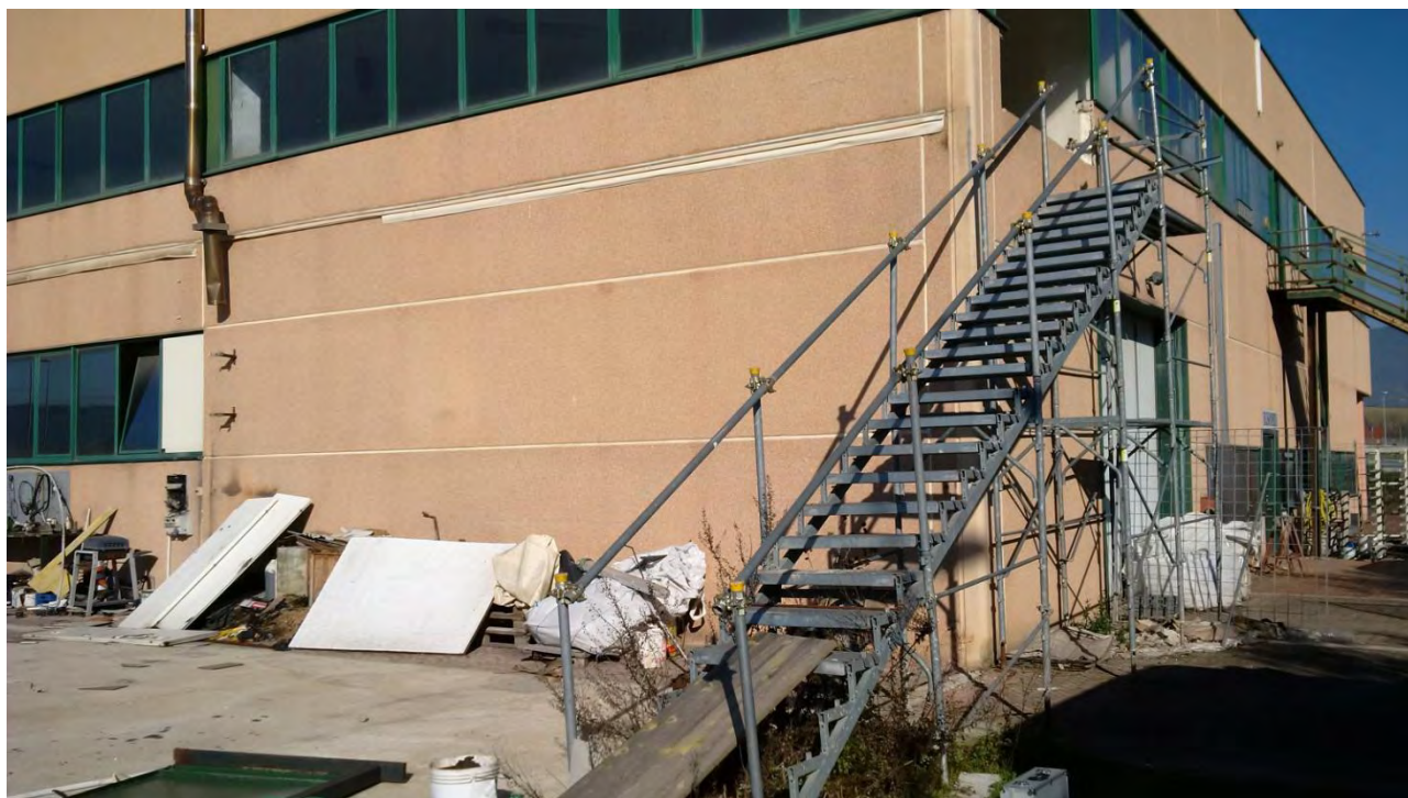
Foto 11 SCALA DI ACCESSO RICAVATA SU PONTEGGIO DA CANTIERE
