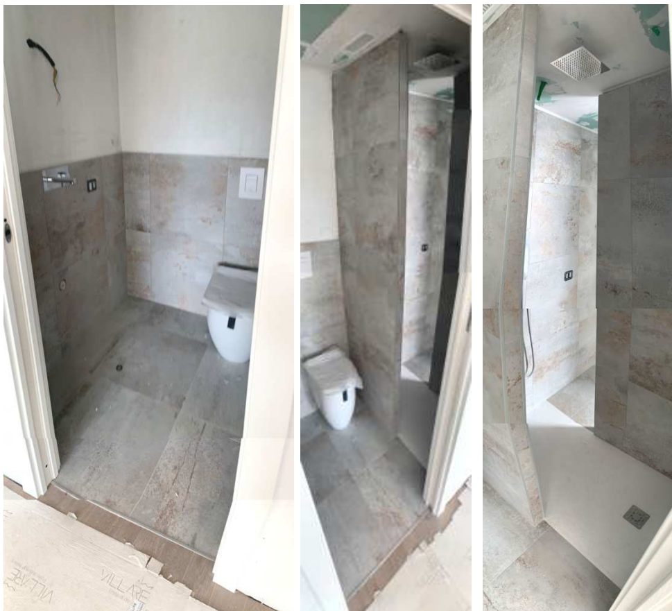
Foto nn. 21-22-23. Piano Terzo. Bagno pag. 7
