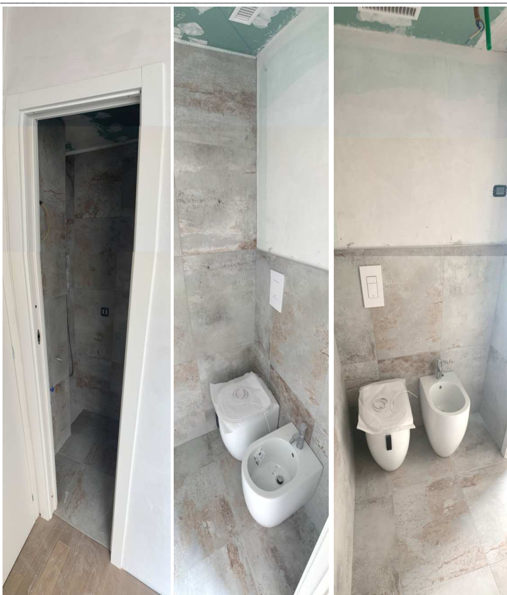
Foto nn. 26-27-28. Piano Terzo. Bagno
