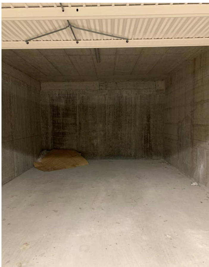
Foto nn. 13-14. Piano Primo Interrato. Box auto
