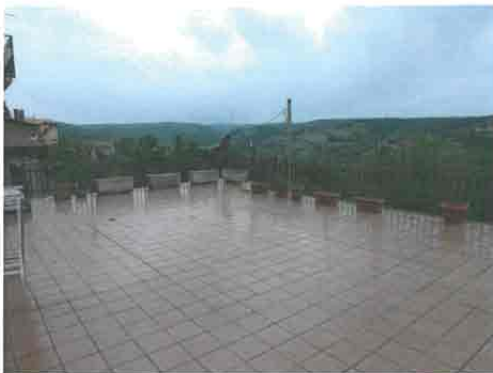
Foto n.19 - Esterno sub.3 p.lla 440, sub.8 p.lla 321, sub.7 p.lla 375, terrazza.
