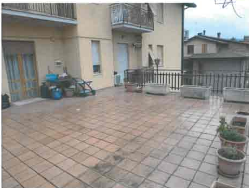
Foto n.20 - Esterno sub.3 p.lla 440, sub.8 p.lla 321, sub.7 p.lla 375, terrazza.
