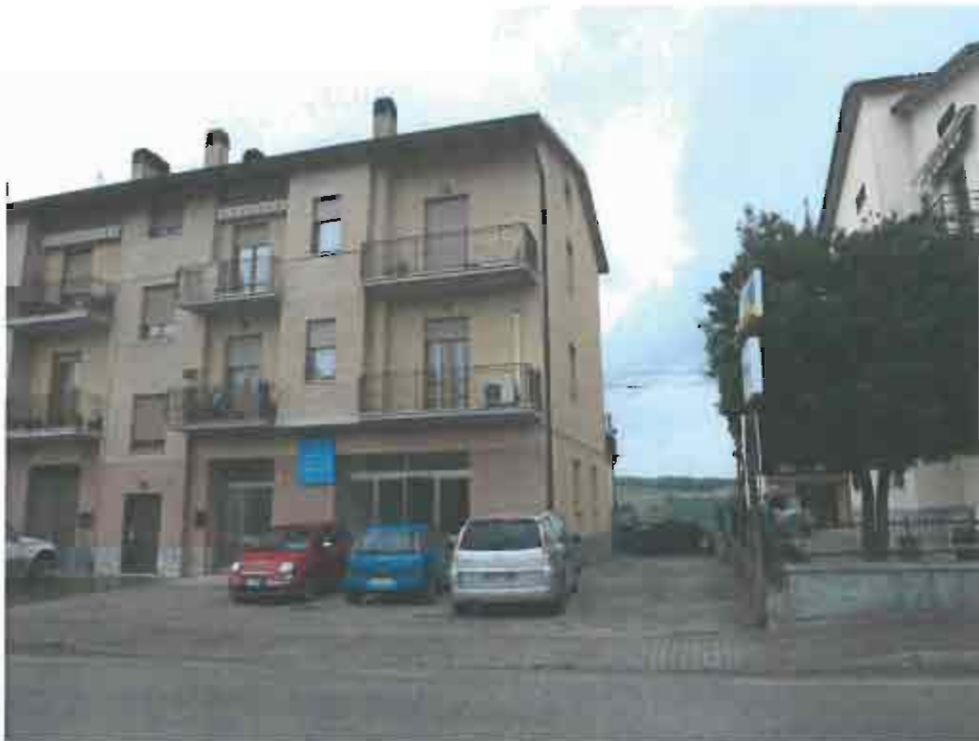
Foto n.1 - Prospetto principale e area esclusiva p.lla 1328
