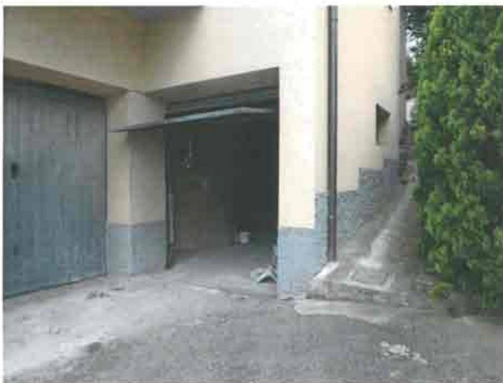
Foto n.3 - Ingresso del locale sub.2 p.lia 251 al piano primo sottostrada
