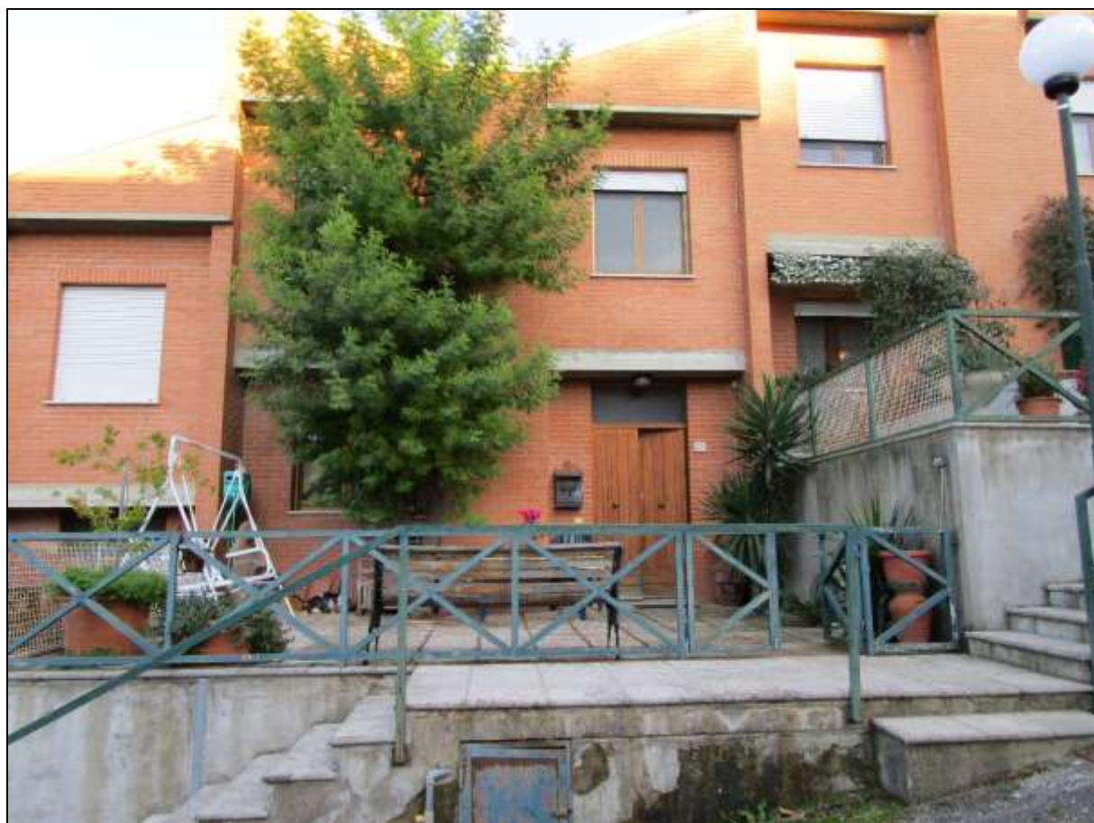
Documentazione fotografica – Esterni lato ovest
