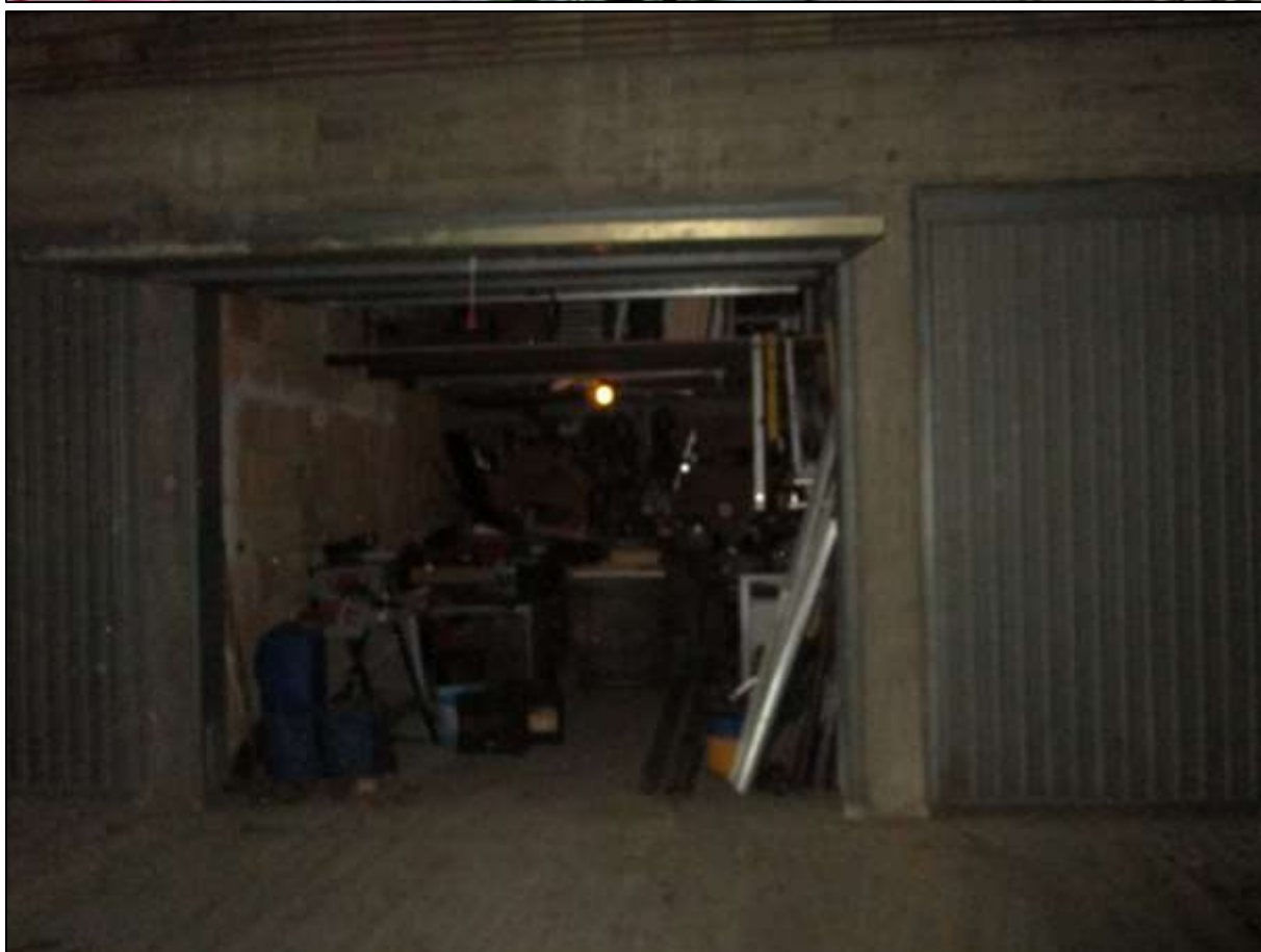
Documentazione fotografica – Esterni lato est e garage
