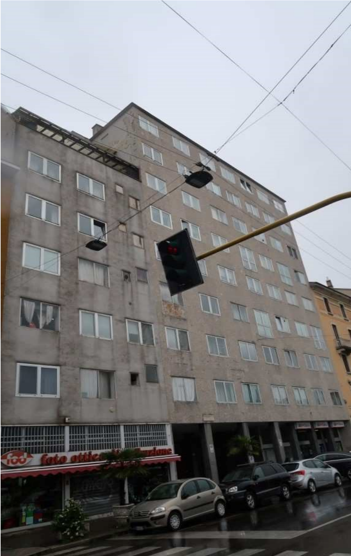
FACCIATA SU VIA PADOVA
